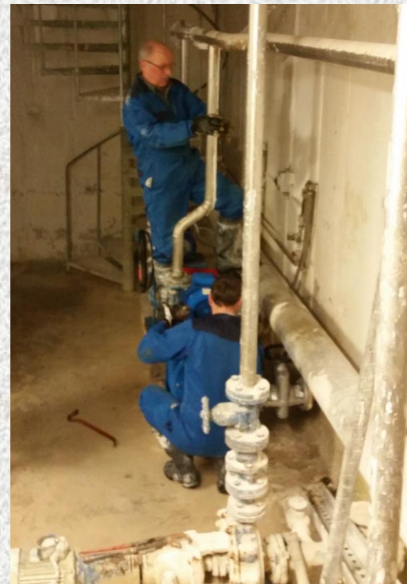
Jorma ja Jarmo asensivat peruskorjattua kalkkiliuospumppua takaisin paikalleen Porrassojalla tammikuussa.
