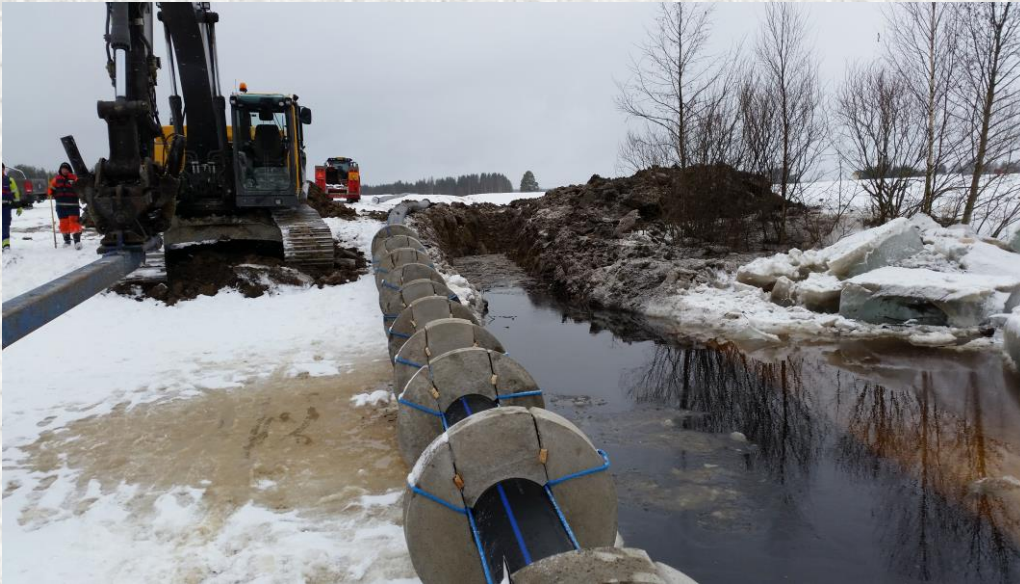
Lapuan suunnan 3. päävesijohto rakennettiin Lapuanjoen ali 100 % betonipainotuksella (80 kg/m) maaliskuussa 2016.
