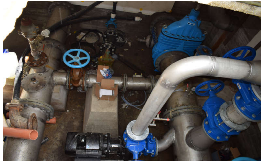
Lapuan suunnan 3. päävesijohdon paineenkorotus rakennettiin onnistuneesti ja edullisin kustannuksin Lakaluoman venttiilikaivoon.
