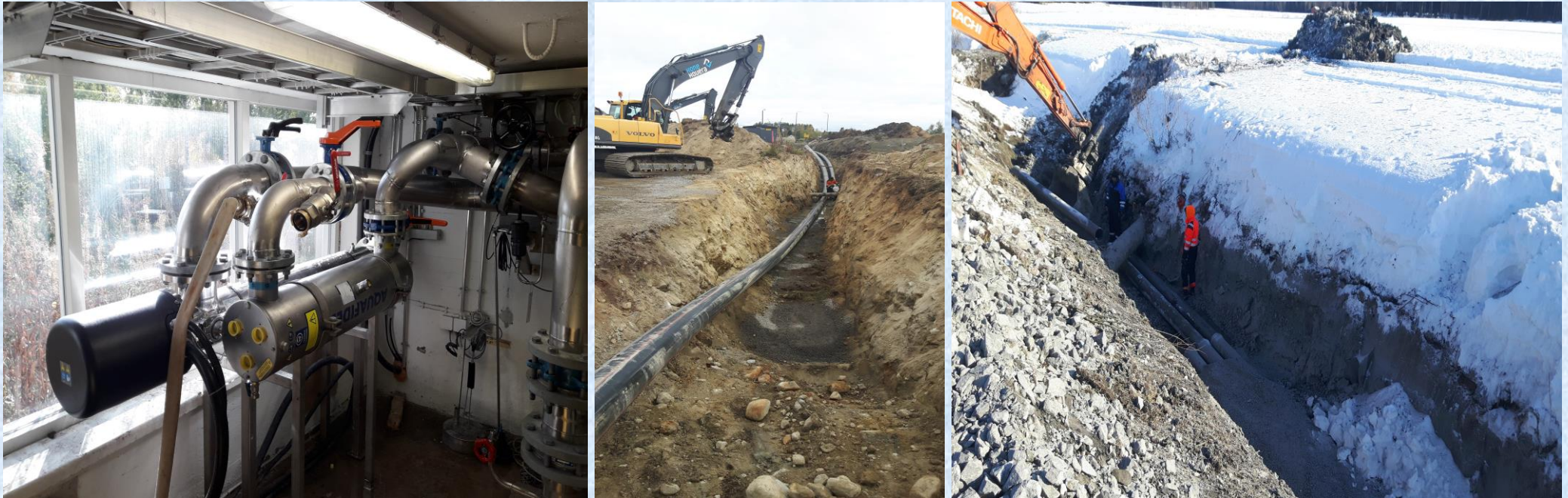
Nahkalaan asennettiin toinen UV-desinfiointilaitte, vanhaa Nurmon päävesijohtoa korvaava DN 300 vesijohto rakennettiin Koverosta Huhdannevalle, ja Jätteenluoma putkitettiin molempien vanhojen Lappakangas-Lapua päävesijohtojen alitse (3 kpl DN 250 PVC).
