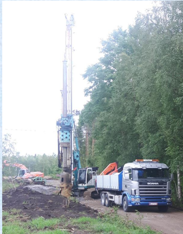
Saukonkylä III ottamon kaivoa porataan
