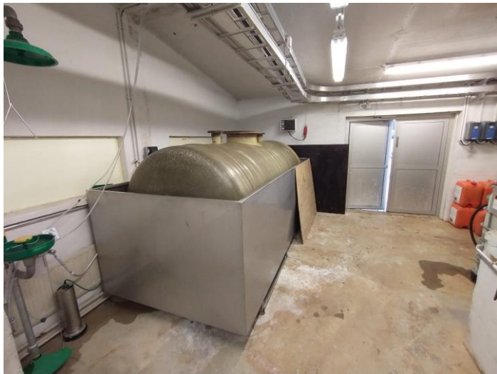
Nahkalan laitoksen uusi lipeäsäiliö varoaltaineen
